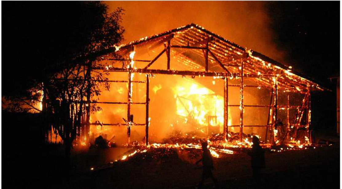
Bis auf die Betondecke niedergebrannt ist die landwirtschaftliche Maschinenhalle mit Heustadel.
